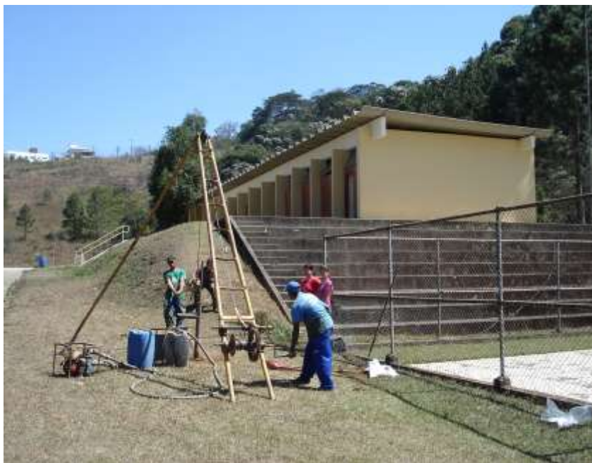
Vista de um tripe de sondagem: Investigação do subsolo para a futura construção de fundações de estrutura de cobertura de quadras poliesportivas no campus da UFJF.
