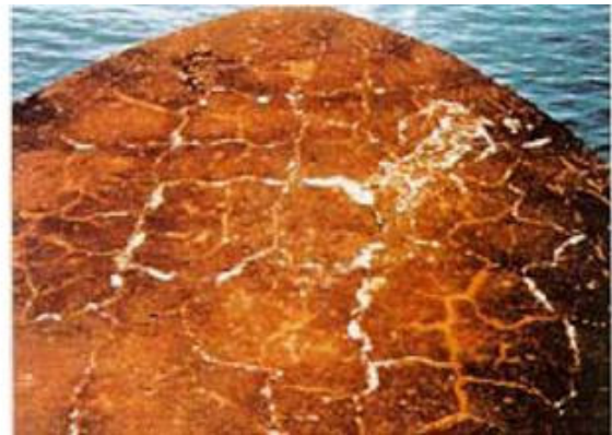
b) Fissuras e deslocamento em um pilar do vertedouro da Barragem de Porto Colômbia.
