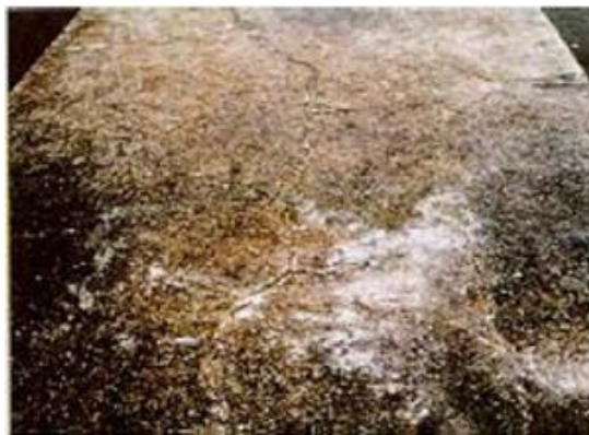
a) Fissuras em mapa na crista de um muro divisorio da calha do vertedouro da Barragem de Mascarenhas de Moraes.
