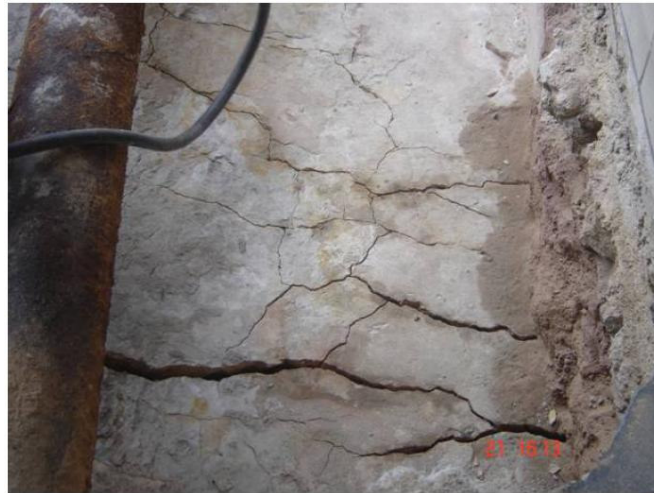
Figura 3.10. Bloco de fundação do Edifício Apolônio Sales (SILVA, 2007)
