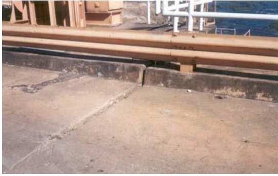
a) Desnívelamento entre juntas e fissuras superficiais (vertedouro / muro de transição).
