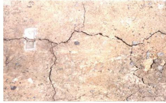
b) Fissuras mapeadas no topo do pilar
