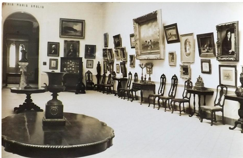
Figura 10: Galeria Maria Amália. Fotografia não identificado. c. de 1960. Fonte: MMP
