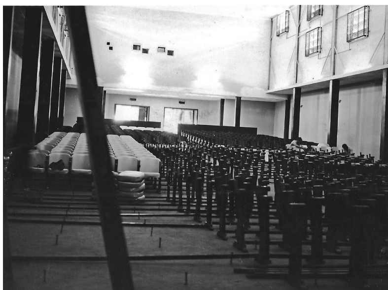
Figura 30 - Reforma do Cine São Luiz em 1969, parte interna. Detalhes para a troca de cadeiras. (Foto: João Batista de Araújo, fonte: blog “Maria do Resguardo”).
