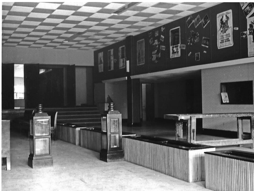
Figura 33 - Reforma do Cine São Luiz em 1969. Detalhes da bilheteria. (Foto: João Batista de Araújo; fonte: blog “Maria do Resguardo”).
