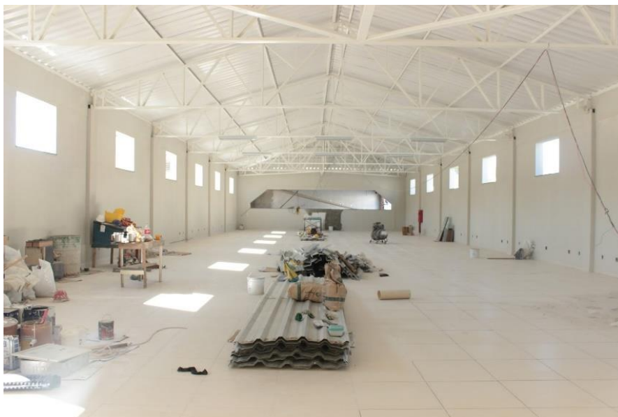
Figura 43 - Galpão localizado no segundo andar do prédio, em dezembro de 2015. (Foto: Gilberto Faúla)
