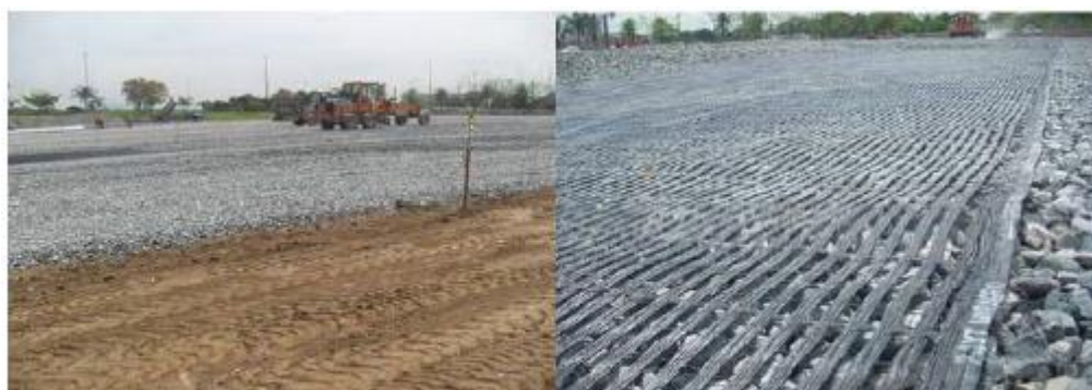
Nivelamento, compactação do solo e colocação da primeira camada de brita
