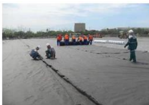
Instalação do geotêxtil não tecido de proteção da face inferior da geomembrana
