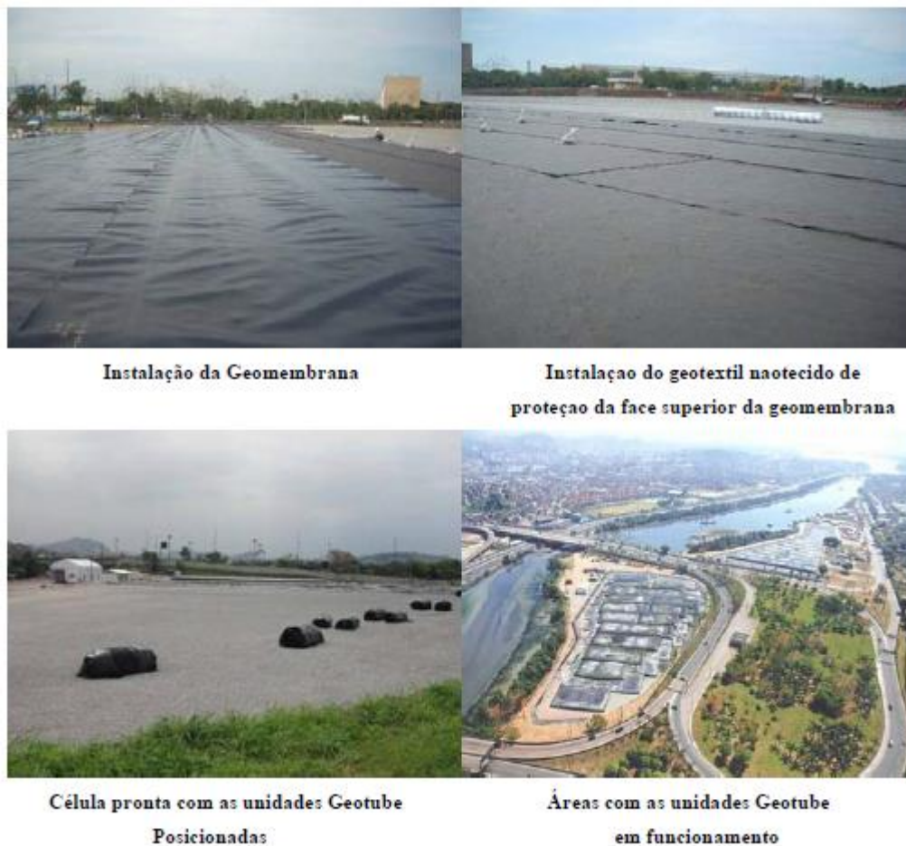
Figura 13: Instalação das células de tubo geotêxtil
